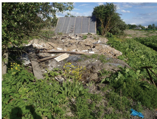
Рисунок 6.30 – Захламление территории строительными отходами Славянка
