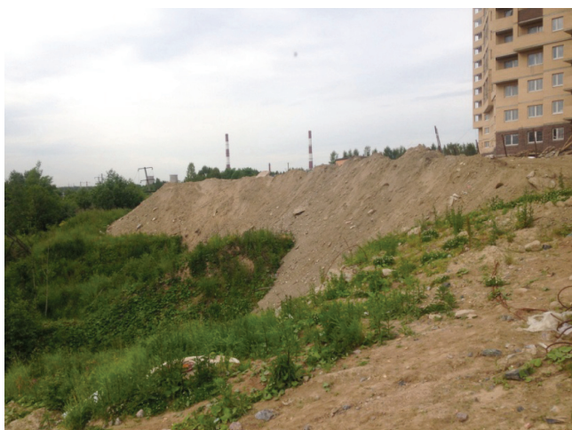
Рисунок 6.18 – Размещение отвалов размываемых грунтов пределах прибрежной защитной полосы реки Охта возле строительной площадки в д. Новое Девяткино
