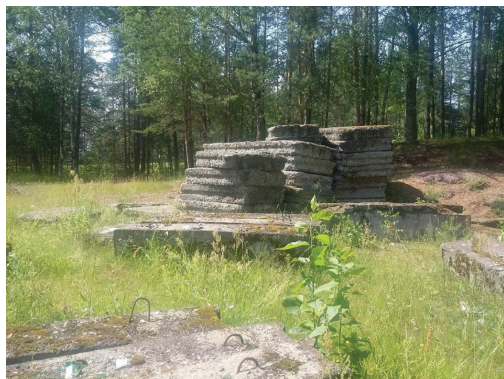
Рисунок 6.20 – Замусоривание территории водоохранной зоны реки Оять строительными отходами
