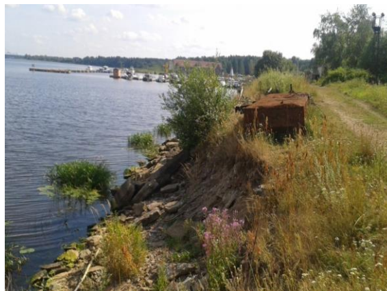
Рис. 6.2. Обрывистый берег с разрушенным берегоукреплением, р. Волхов
