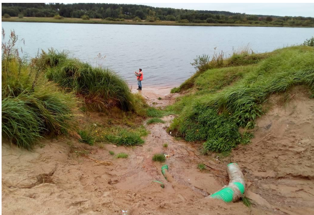
Рис. 6.2- Сброс воды, эрозия берега.
